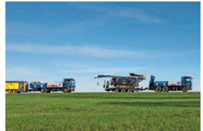
Erdsondenbohrung mit BauGrund Süd
