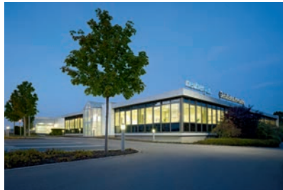
Neuberger Gebäudeautomation in Rothenburg o.d.T.
